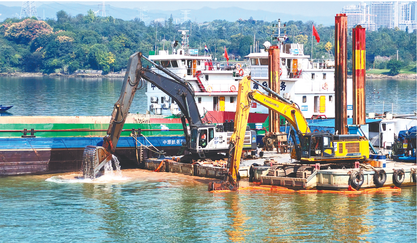
10月10日，三峡水运新通道葛洲坝航运扩能工程上下游围堰正式开工。图为上游围堰施工作业现场。（湖北日报全媒记者 刘曙松 摄）
