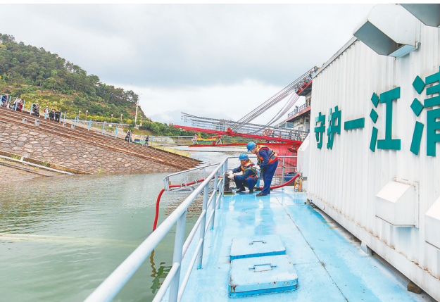
岸电系统为三峡游轮提供绿色电能，船员只需扫码就能接通岸电，实现静音停泊，降低燃油消耗。
