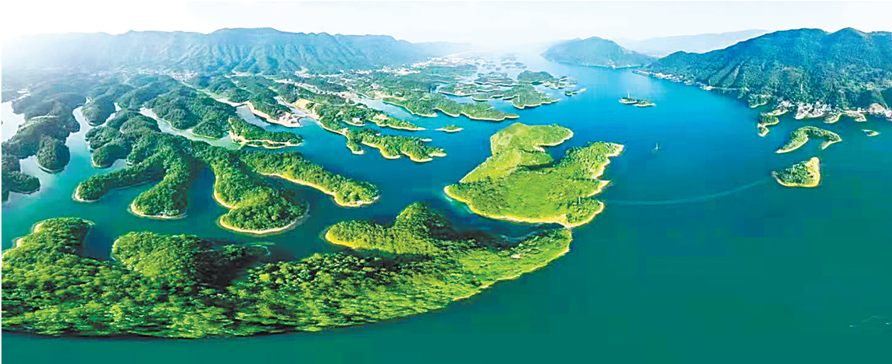
航拍王英水库,千岛镶嵌湖面,碧水绵延群山,是鄂南重要的综合性水利枢纽与水源。(省王英水库管理局供图)
