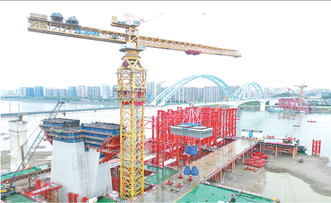
宜昌长江公铁大桥南岸8号主塔首节钢塔吊装作业。（湖北日报通讯员 苏弘鸣摄）
