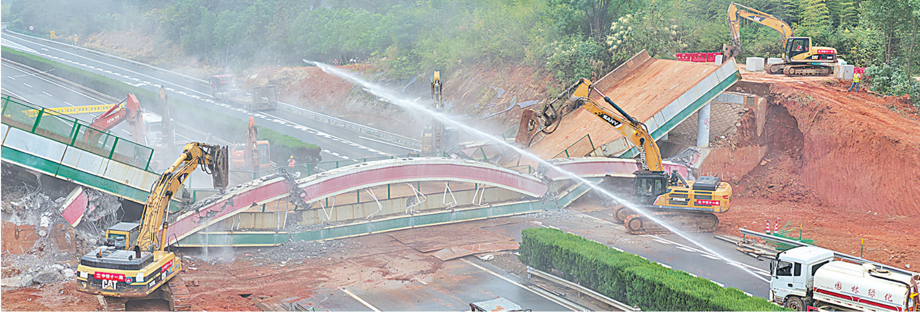
京港澳高速湖北南段改扩建拆桥现场。（湖北日报见习记者 张静远 摄）
