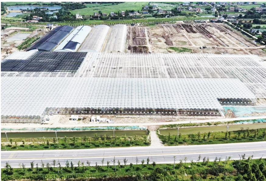
正在建设的九丰项目。
