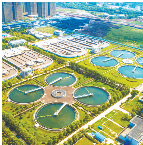
武汉市黄家湖污水处理厂一、二期厂区全景。
