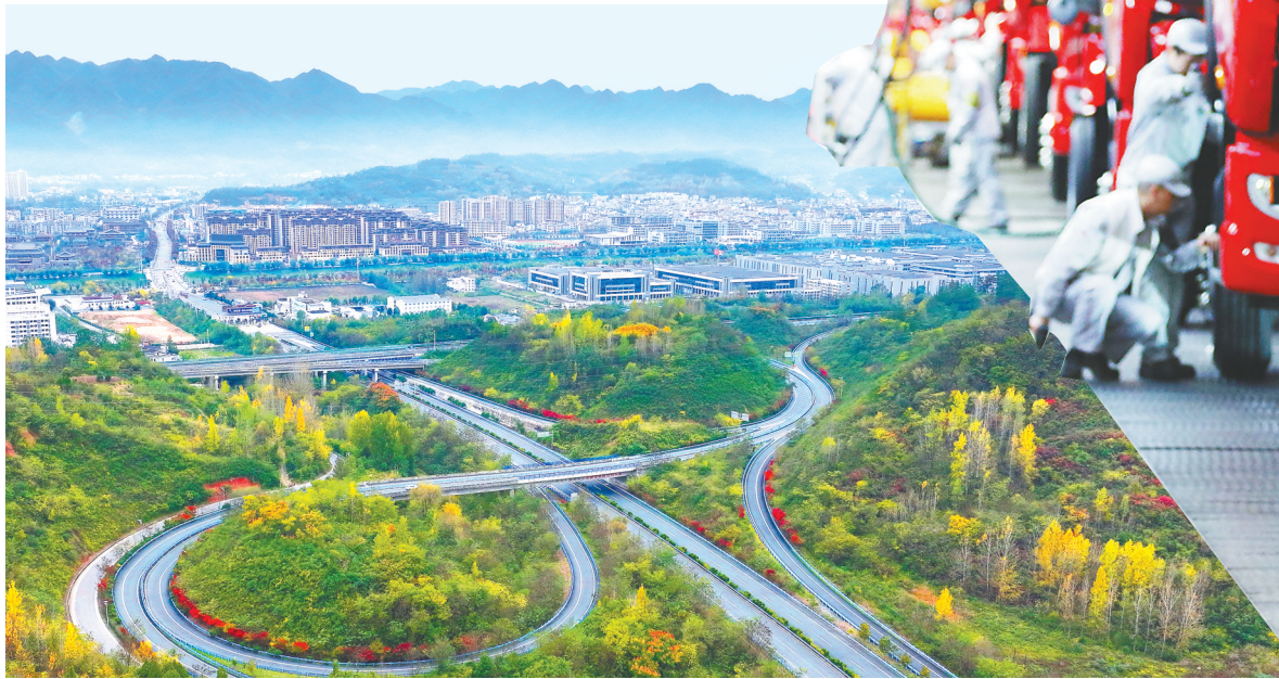
麻安高速与呼北高速穿越十堰市房县境内。(视界网 张启龙 摄)
