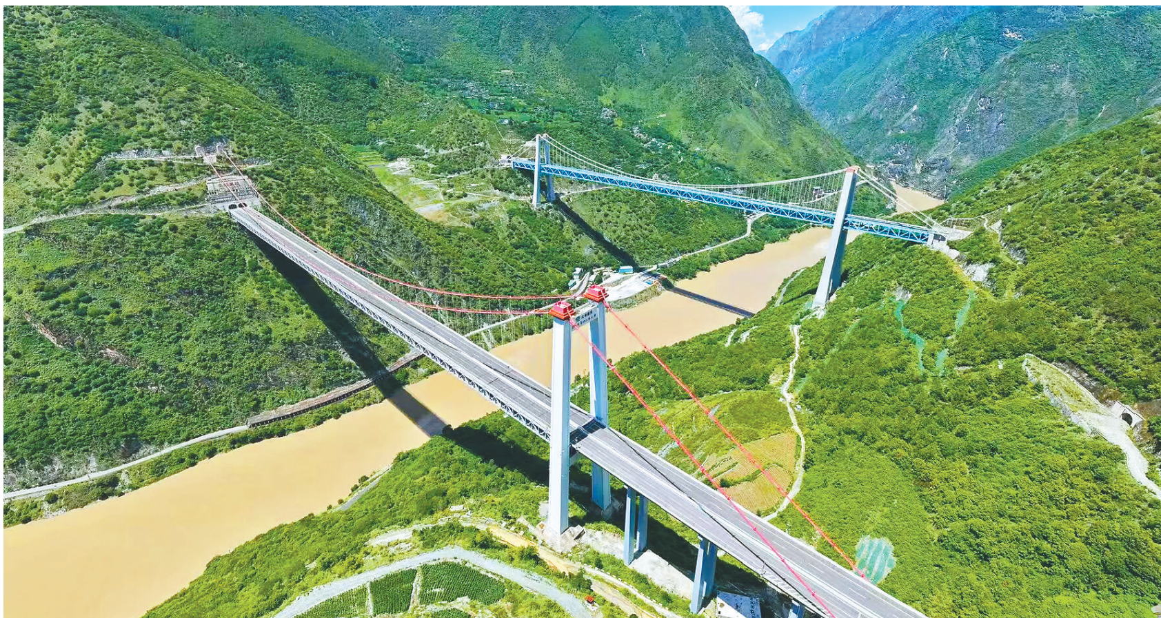
在云南丽江玉龙县，虎跳峡金沙江特大桥（左）与金沙江铁路大桥并肩横跨大江，一红一蓝两座桥矗立峡谷之间，昔日天堑变通途。
