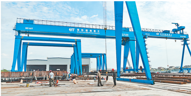
宜都绿色智能船舶产业园内,湖北海科船舶重工项目施工现场。 (湖北日报通讯员 孙玉敏 摄)
