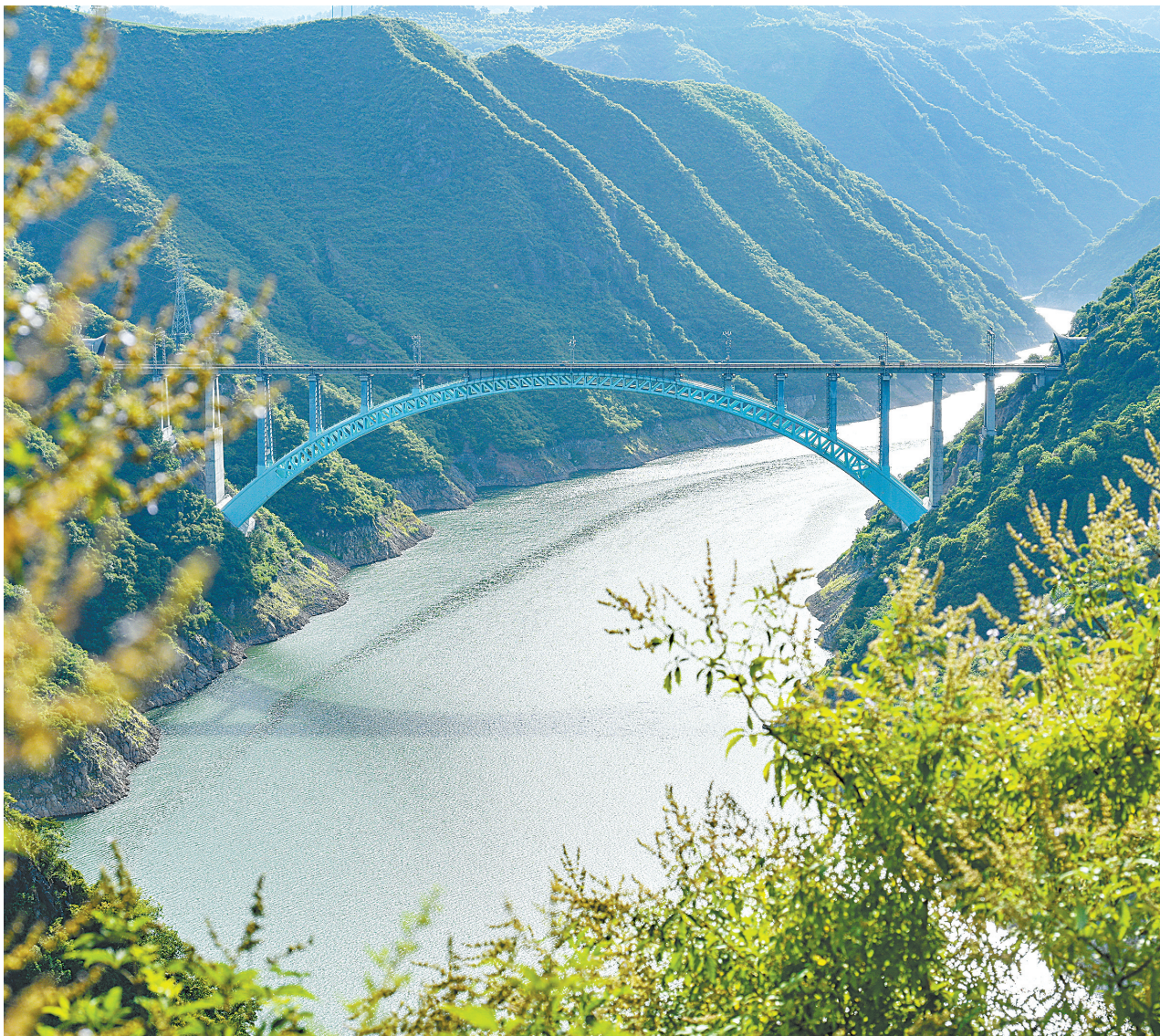
浩吉铁路洛河大桥凌空飞架，220米主跨一跨过河，摘得中国建筑行业工程质量最高荣誉——“鲁班奖”。
