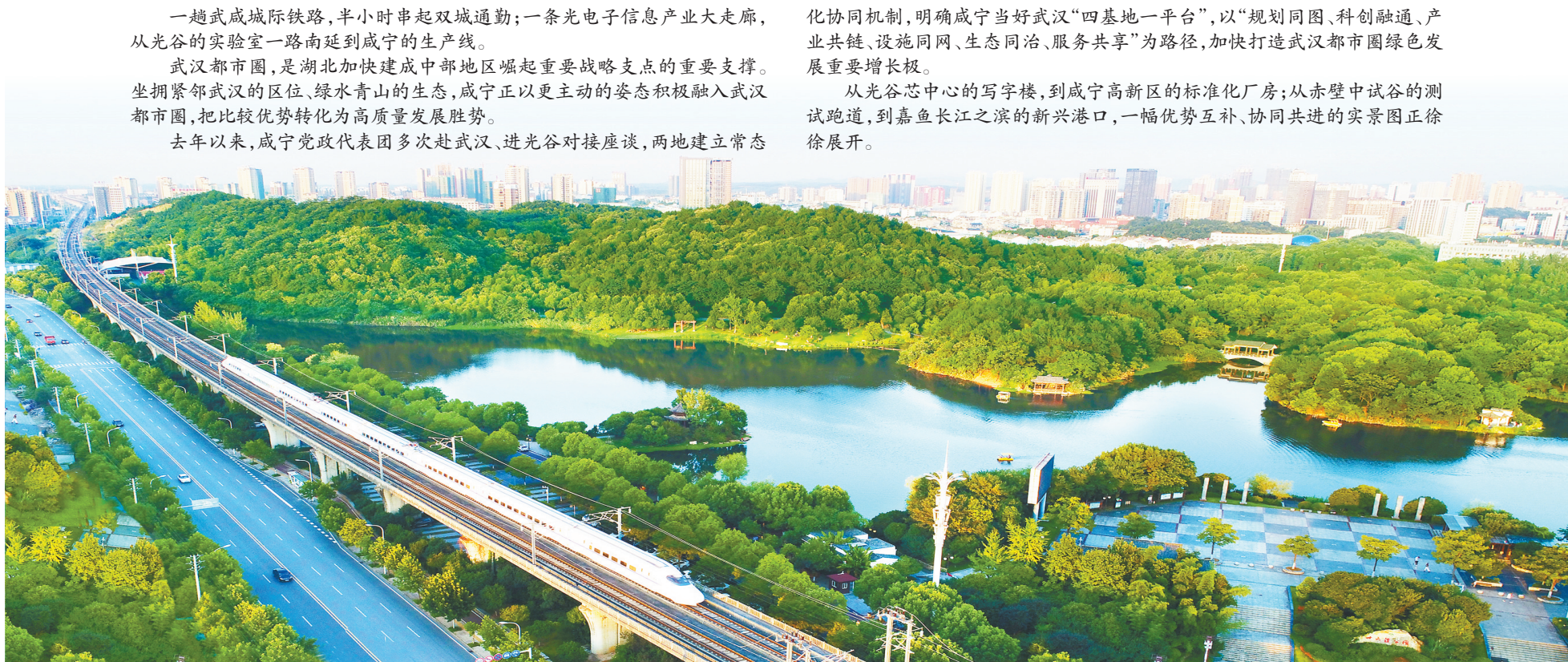
武咸城际铁路穿城而过。(夏正锋 摄)
