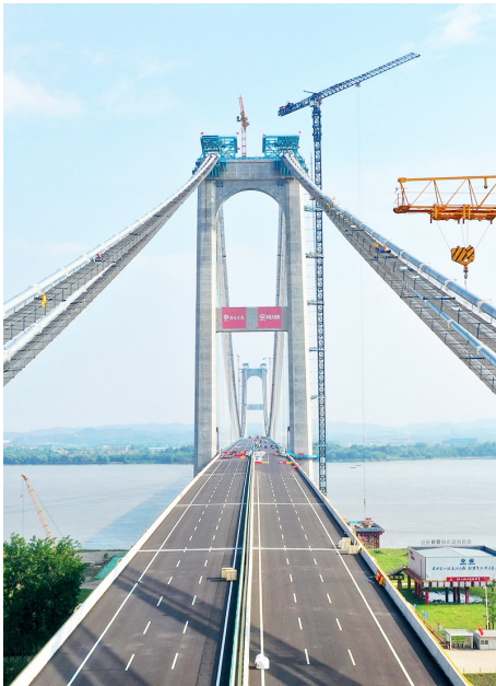
燕矶长江大桥建设加快推进。
