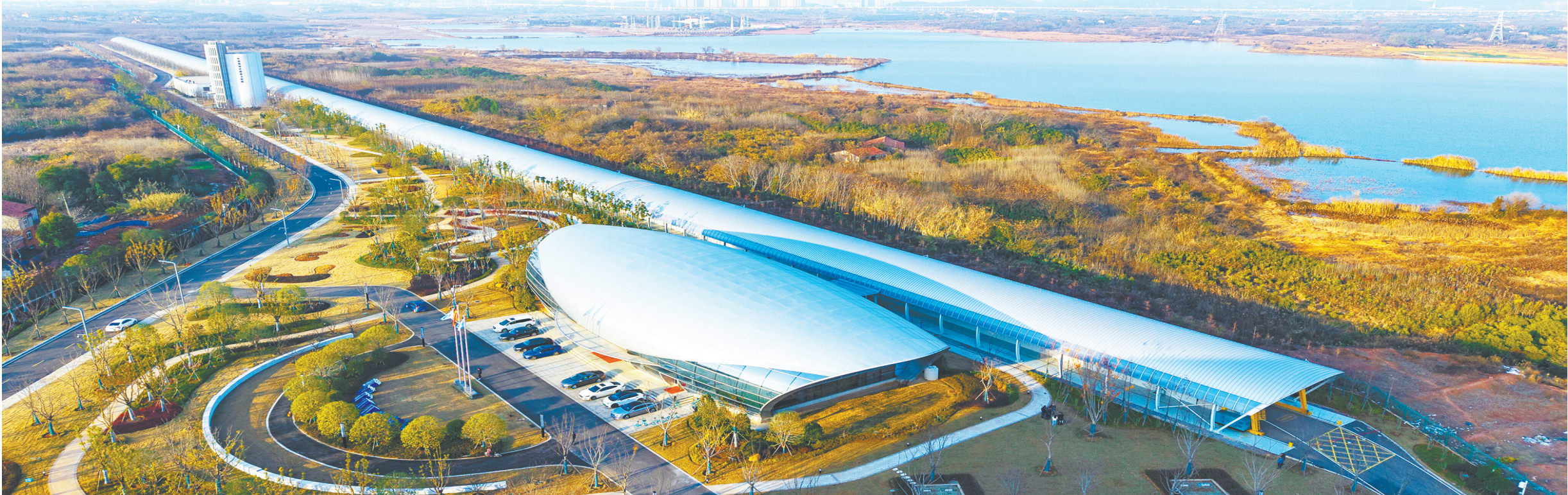
东湖实验室高速磁悬浮测试线突破时速800公里。(魏铤 摄)
