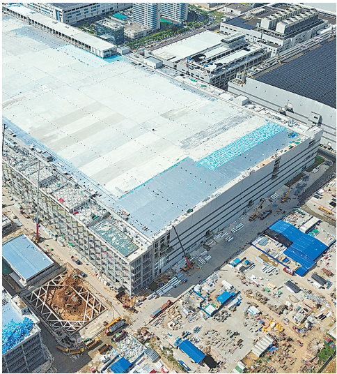
航拍正在建设中的华星T8项目主厂房。(湖北日报通讯员 何咏燊 摄)
