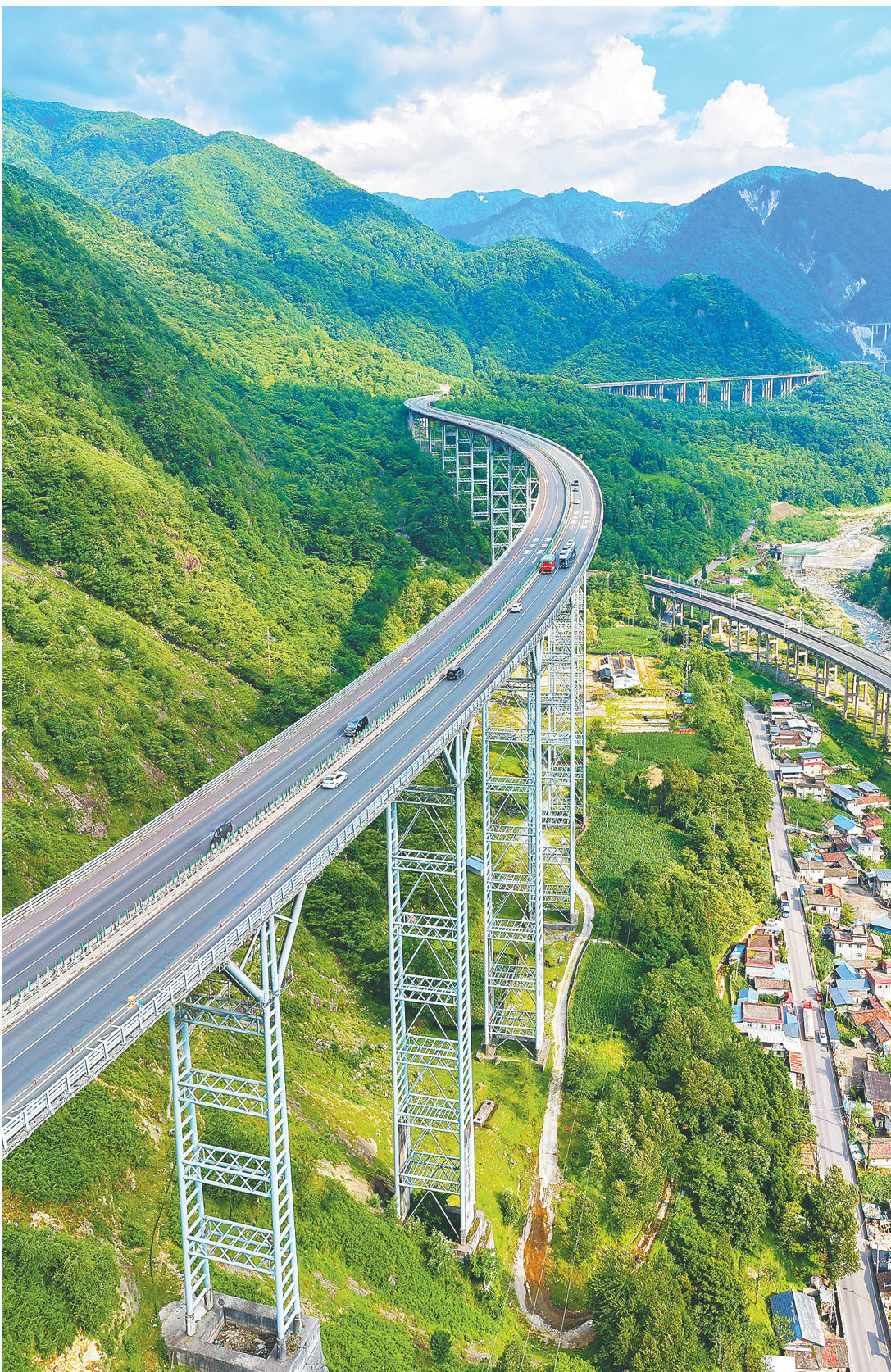
雅西高速千海子特大桥尽显大国工程的磅礴气势。
