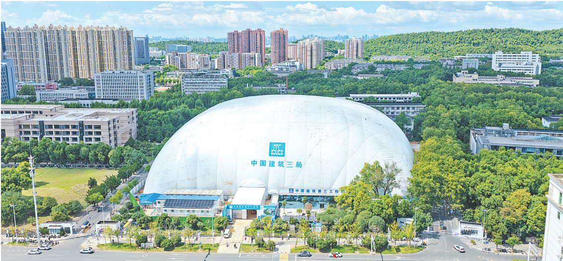
航拍位于华中科技大学校内的基坑气膜。（湖北日报见习记者 张静远 摄）
