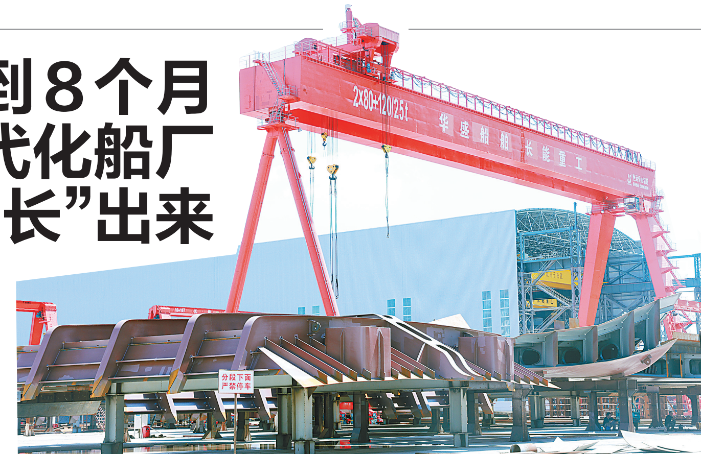
湖北华盛船舶重工有限公司厂区内,龙门吊实施船体钢结构构件吊运作业,船舶分段拼装工作有序推进。(湖北日报通讯员 石蕾 摄)
