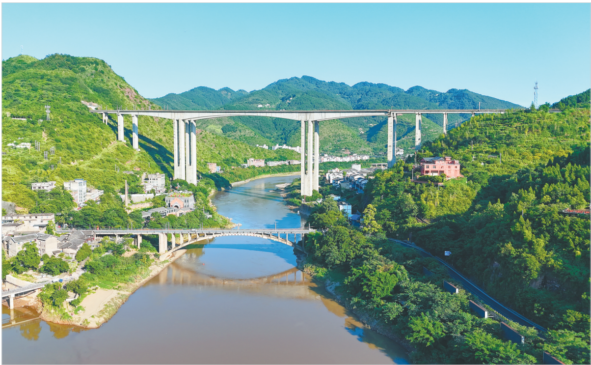
贵州省习水县土城渡口，土城大桥(前)与土城特大桥同框。
