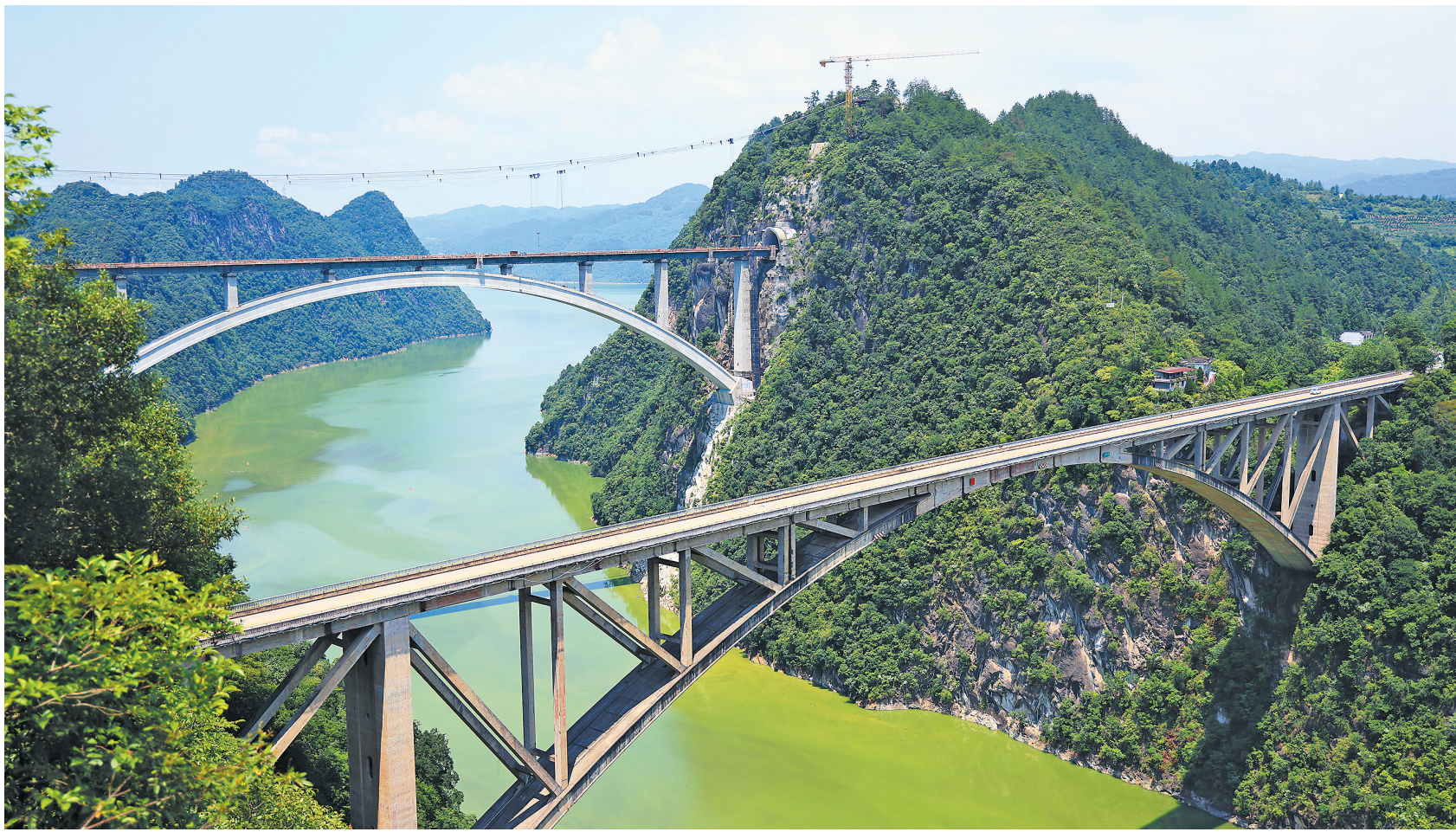
远处乌江铁路南北延伸线乌江特大桥正在建设中。
