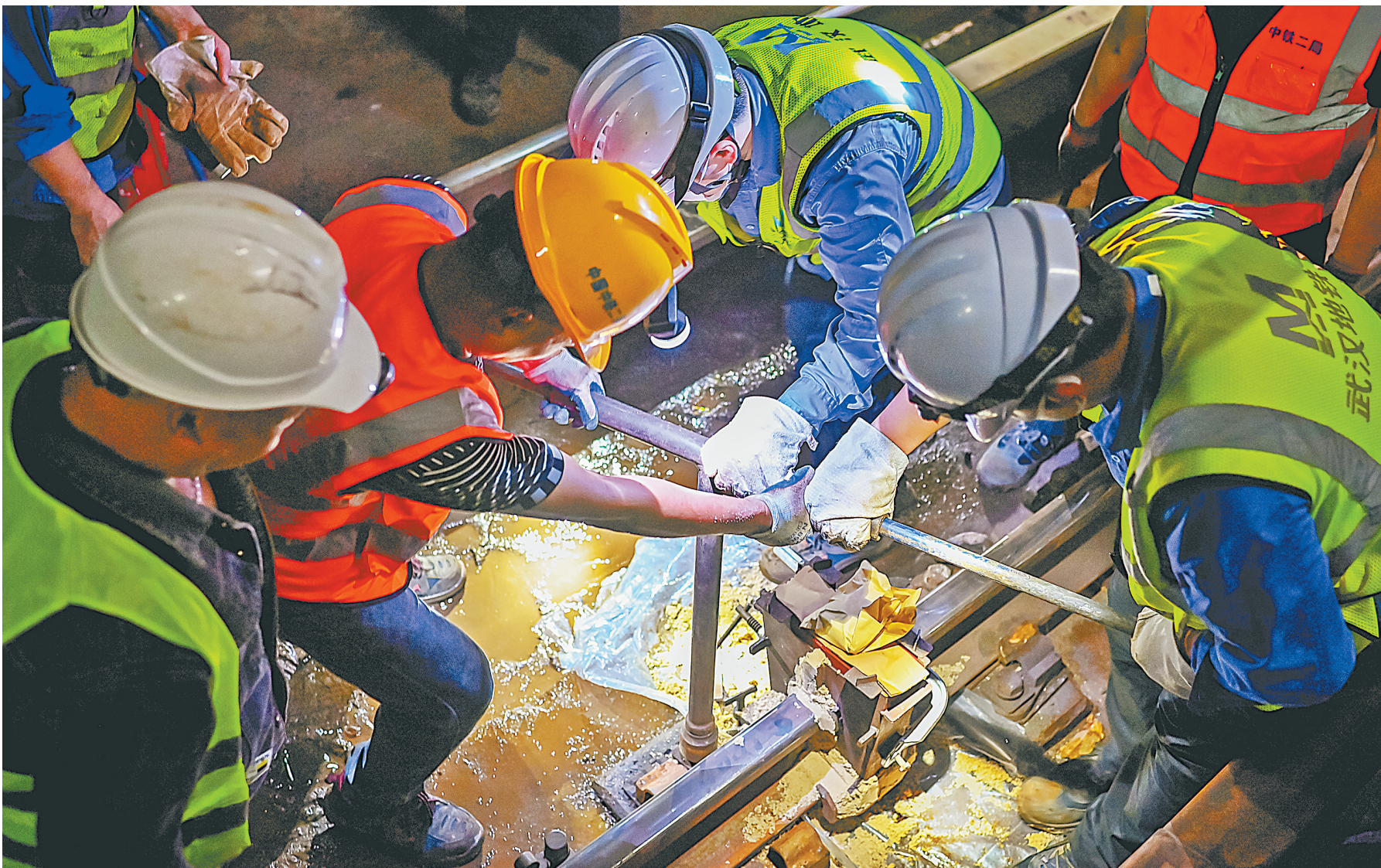
8月11日2时19分,在2号线宝通寺站,工作人员正在地铁隧道内换轨。
