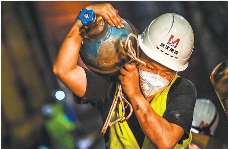
8月20日3时20分,部分施工设备开始撤离现场。
