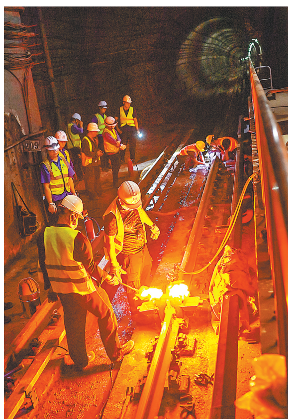
8月11日2时13分,在2号线宝通寺站,工作人员正在给新钢轨连接处加热。
