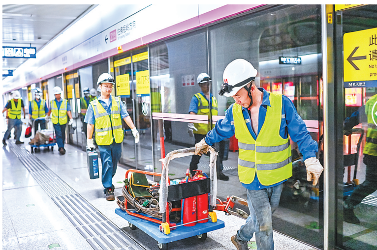
8月20日1时15分,地铁线路检修工人进入2号线路雄路站的隧道内换轨。
