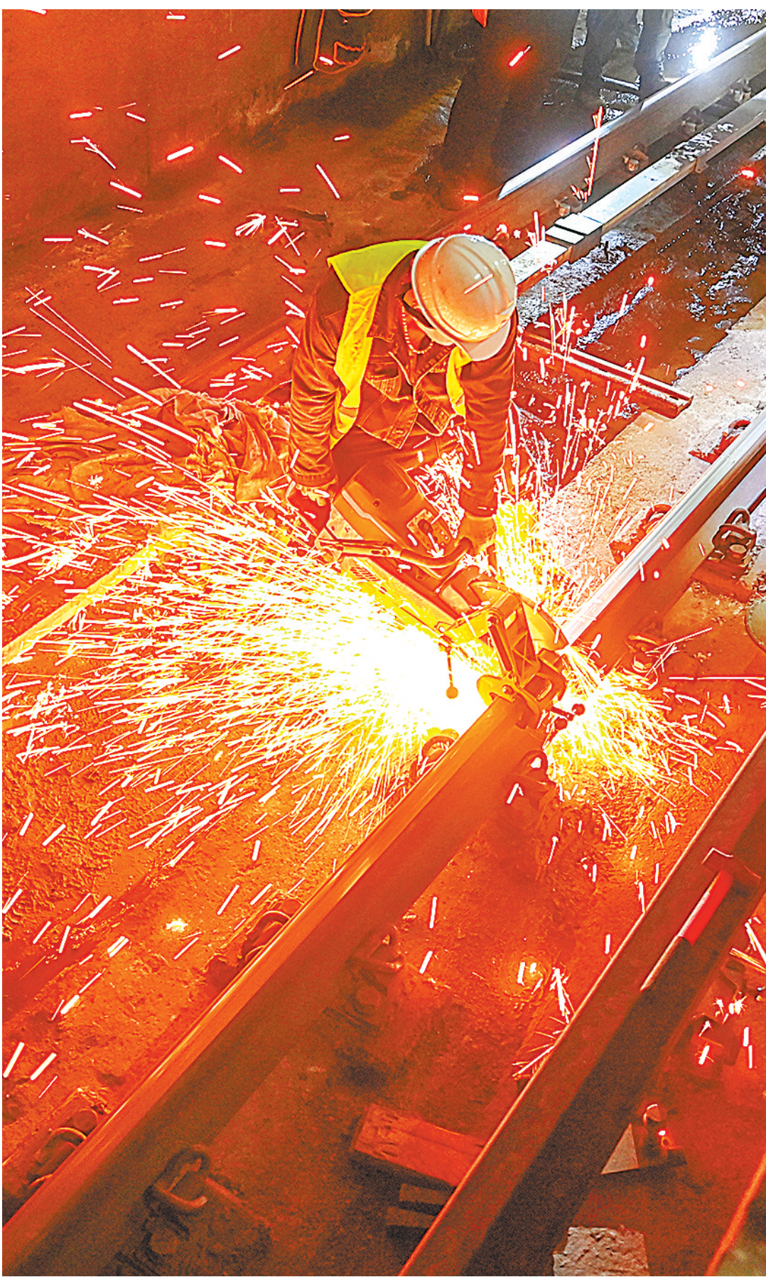
8月11日1时24分,施工人员在2号线宝通寺站切割旧钢轨,瞬间火花四溅。
