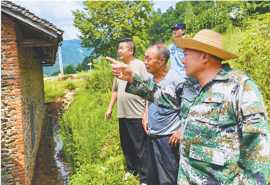
8月18日，代全华（右一）查看村民家房屋受损情况。
