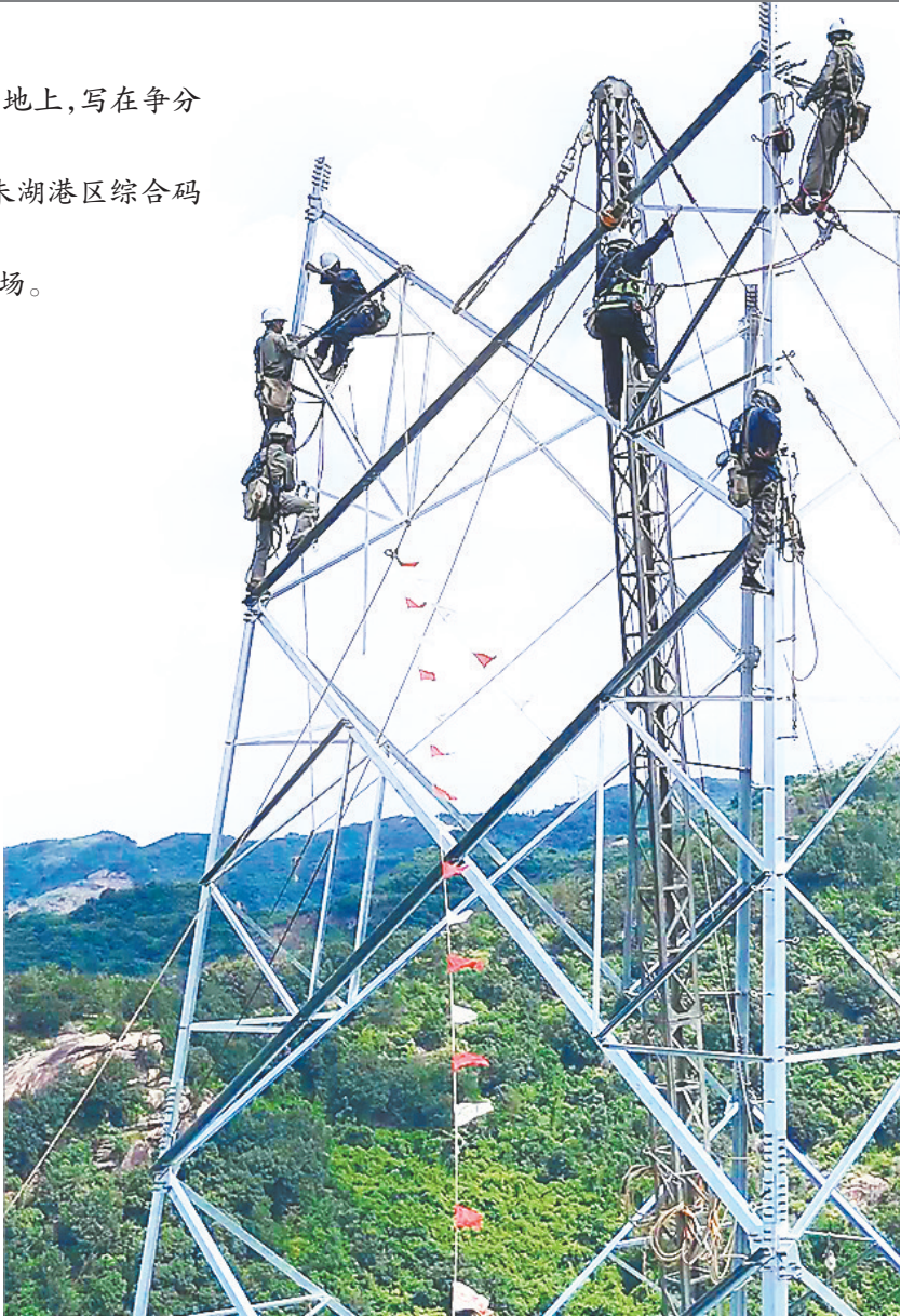
国网孝感供电公司施工人员在蒸腾的暑气中全速推进220千伏送出工程架设任务。（湖北日报通讯员 余健兵 摄）
