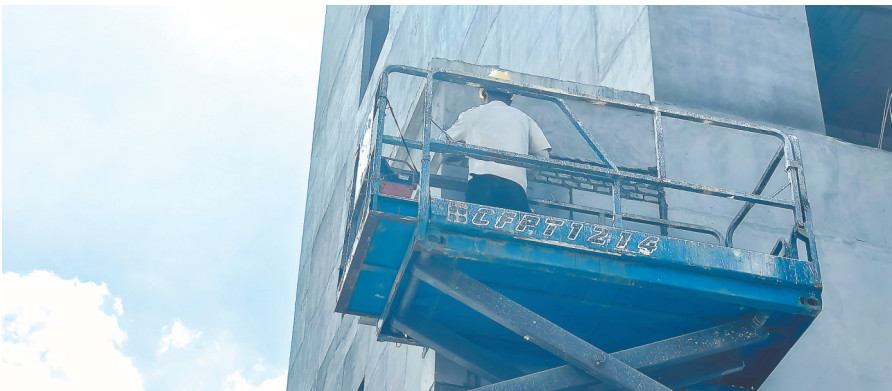
背阴处，工人正在进行砌墙作业。（湖北日报通讯员 陈峥嵘 摄）
