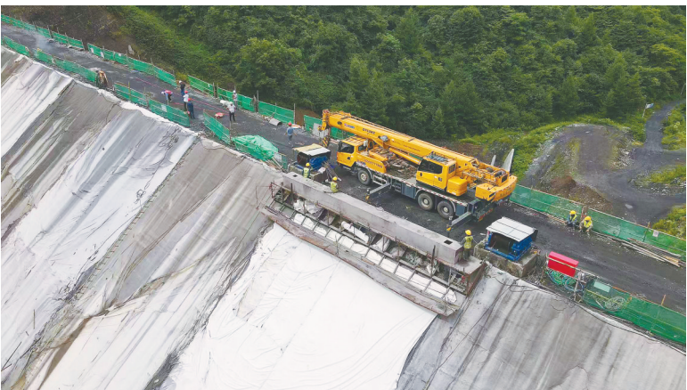
岩板河水库大坝面板浇筑现场。（受访单位供图）
