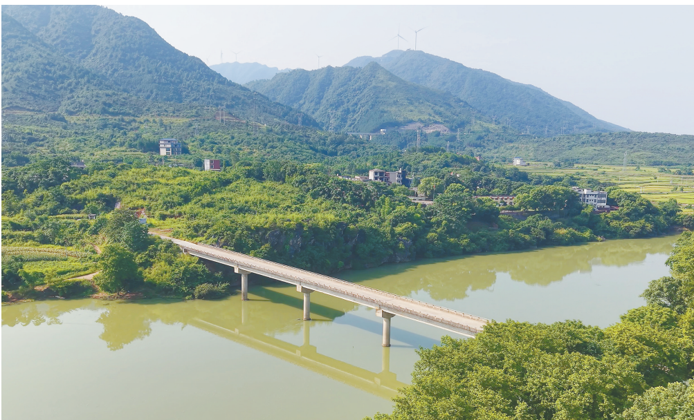
静卧于绿水青山间的道县审井大桥。
