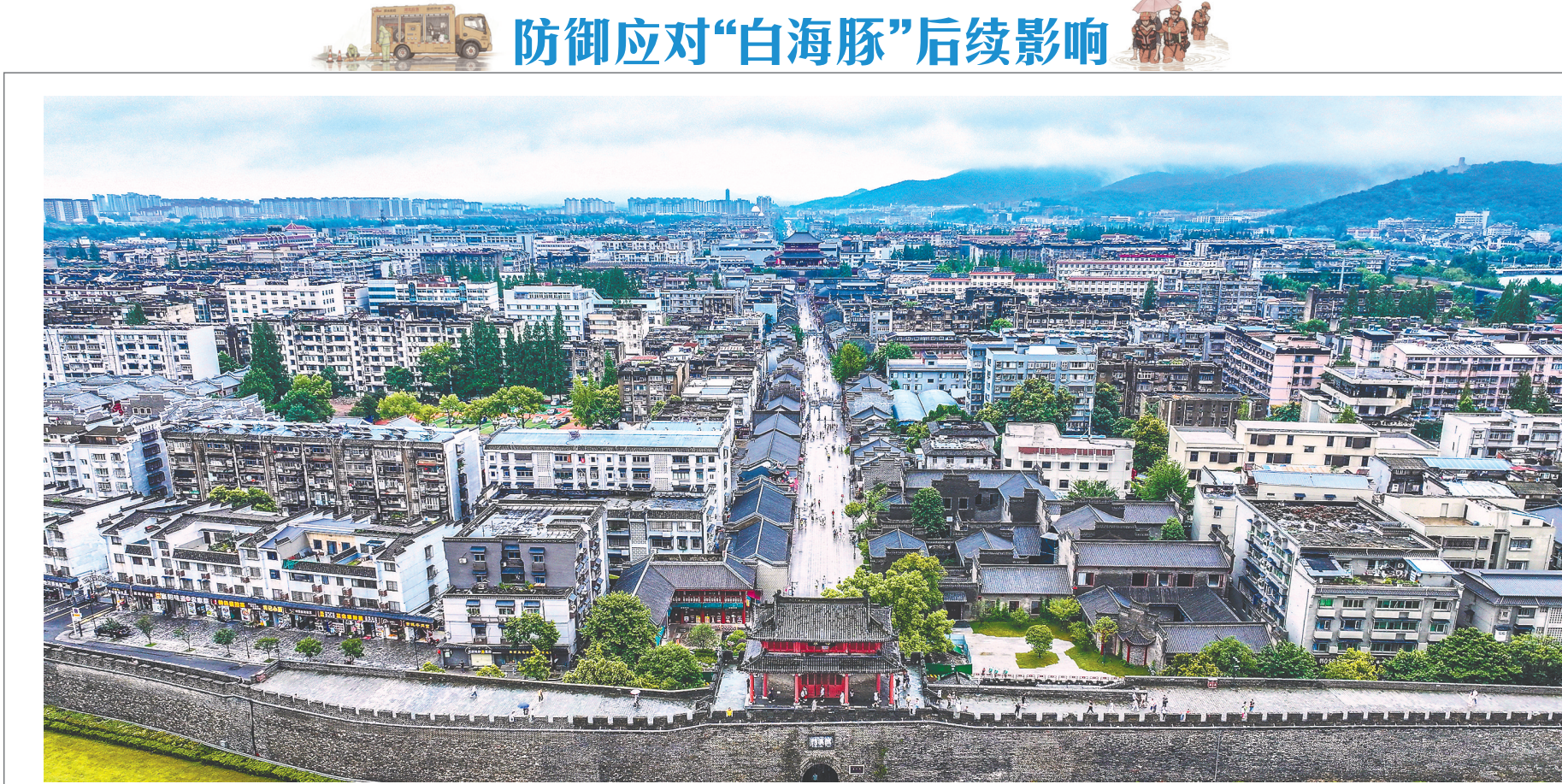
8月14日,暴雨后的襄阳古城,地面干净如洗,无积水痕迹,街巷间行人渐多。今年初,襄阳市襄城区古城片区启动“拆墙并院”城市更新行动,低洼片区全面完成雨污分流,生活污水和雨水两套管网彻底分离,排污管网全部加粗,大幅提升排水速度。(湖北日报全媒记者 赵伯然 摄)
