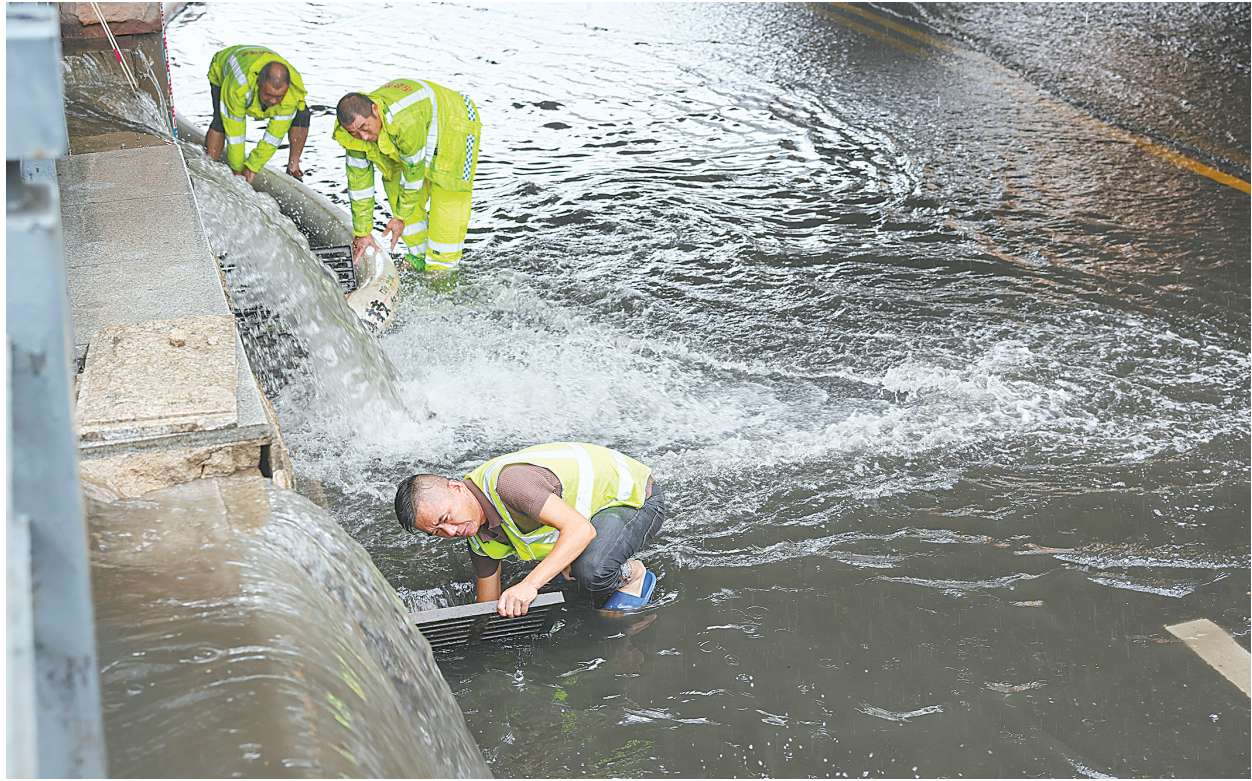
8月11日，襄阳市政管理处工作人员在襄城区东门口铁路涵洞架设抽水泵进行排水作业。（视界网 杨东 刘紫瑾 摄）
