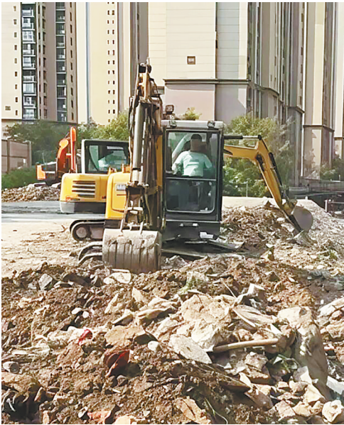
2025年底，江岸区有关部门开始清运渣土堆。
