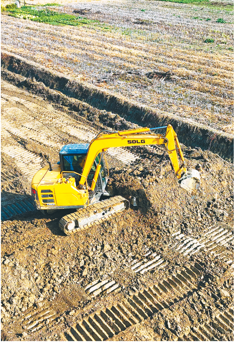
高标准农田项目施工现场。
