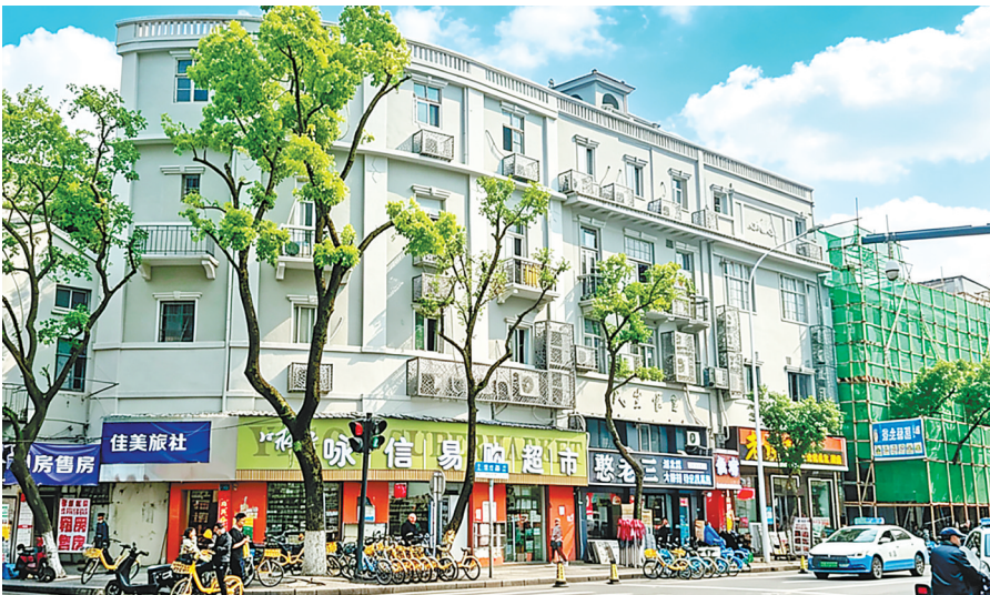
7月底,武汉市江汉区民生路改造基本完工,曾经的“空中蛛网”不见踪影,老街区露历史肌理,亮起新招牌。(受访者供图)
