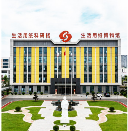
湖北金博士新材料科技有限公司科研大楼。
