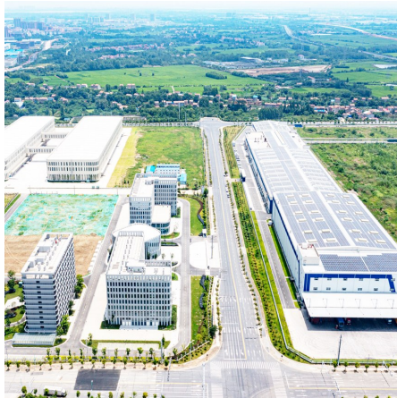
恒安(孝感)家庭用品有限公司建设屋顶分布式光伏。
