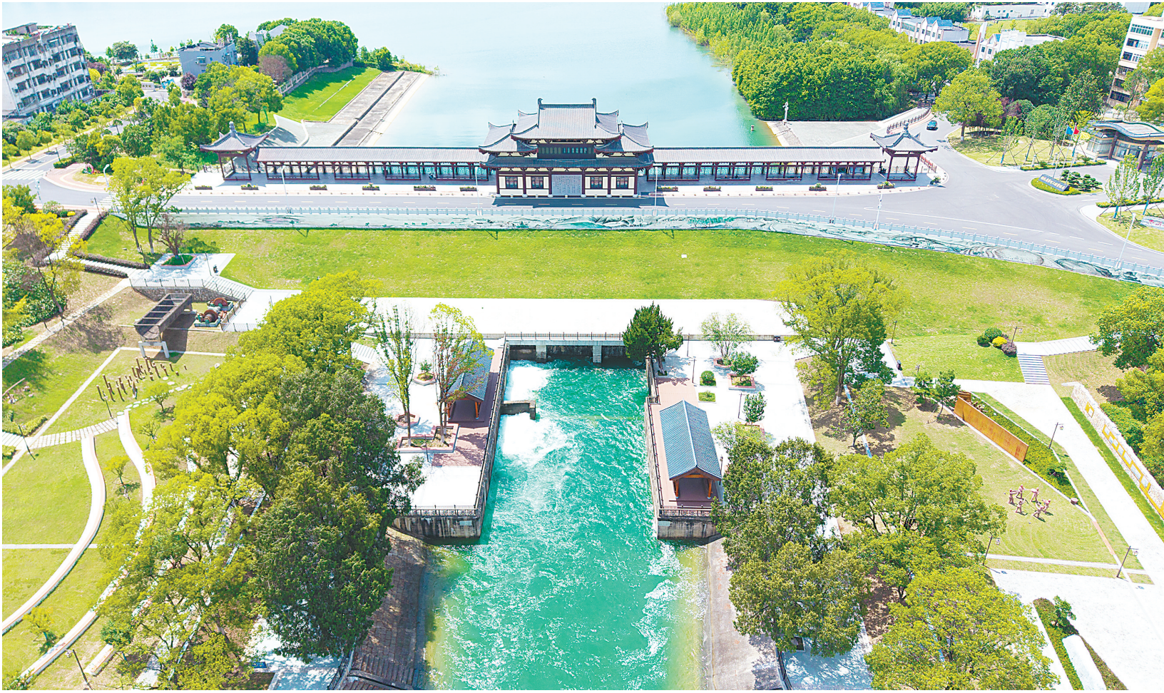
漳河水库渠首闸开闸放水。(湖北日报通讯员 王松 摄)
