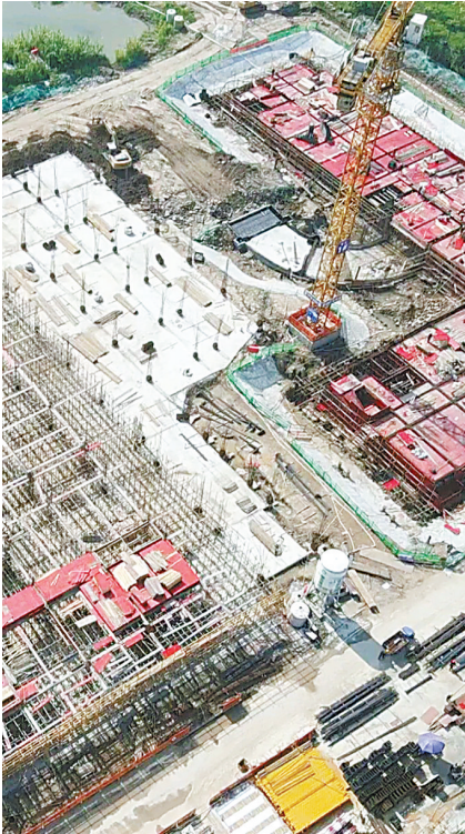
五方光电三期施工现场全景。
