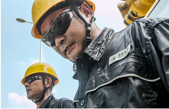
迎峰度夏期间,国网湖北电力员工开展带电作业。(胡斌 摄)
