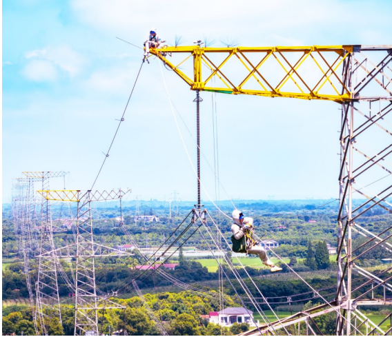
国网湖北电力员工对三峡外送500千伏三江三回线路开展带电检修。(陈军 摄)
