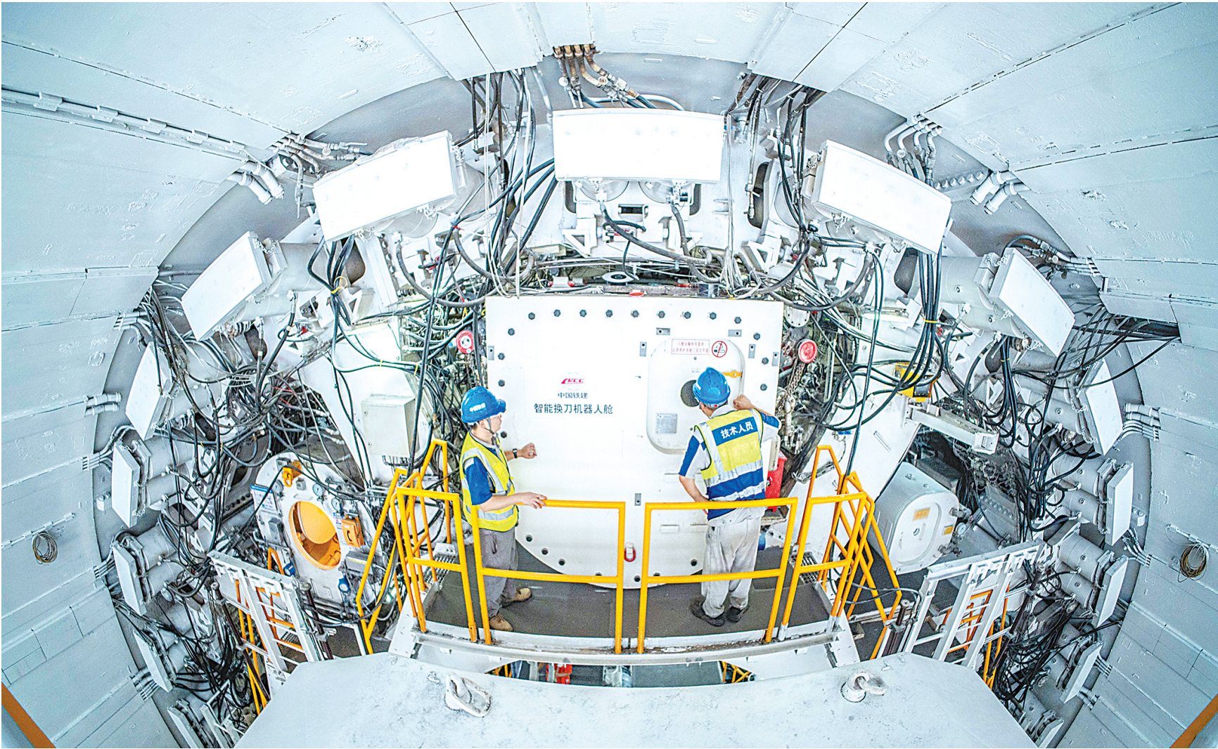
6月25日,在厦金大桥(厦门段)环岛路隧道“厦金号”盾构机掘进现场,国产智能盾构换刀机器人正式投用。机器人整机软硬件实现100%国产化,拥有完全自主知识产权。
