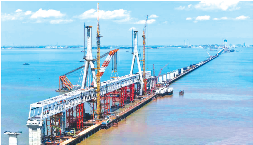
7月26日,由在鄂央企中交二航局承建的杭州湾跨海大桥南航道桥钢桁梁全部架设到位。(受访单位供图)
