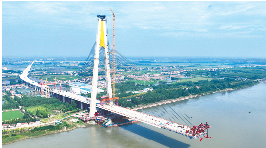
正在建设的观音寺长江大桥。
