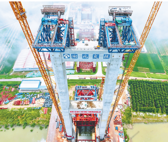
正在建设的李埠长江公铁大桥。(均为受访单位供图)
