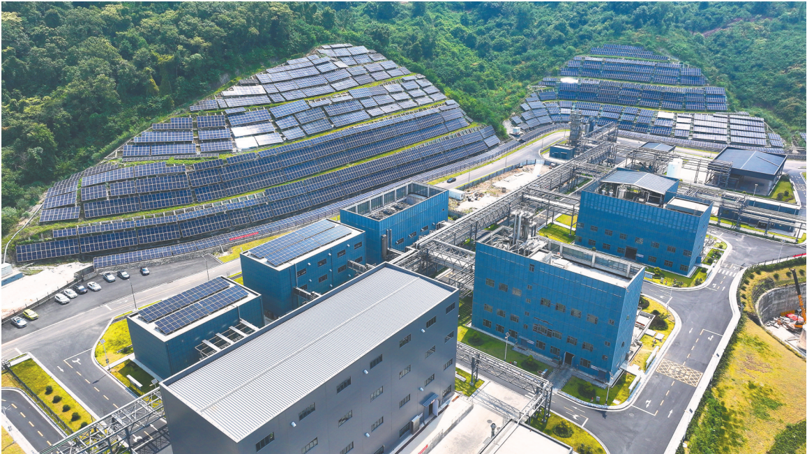
24000多块光伏板顺着边坡铺展开来。(湖北日报通讯员 何磊 摄)
