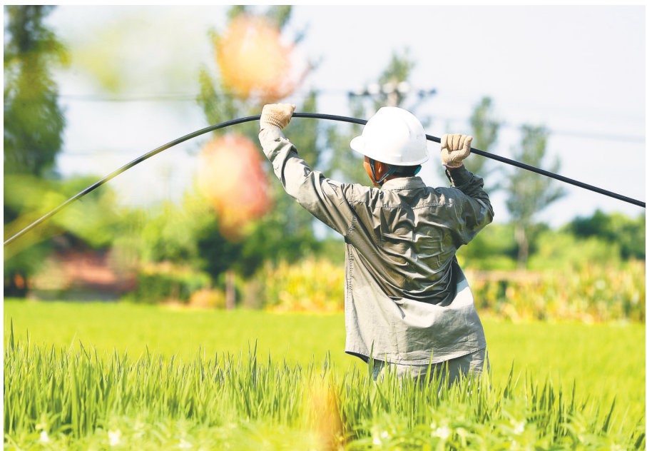
7月15日,沙洋县拾回桥镇香店村的稻田边,国网沙洋县供电公司的电力工人顶着38℃高温,抢架农田灌溉用电专用线,为稻田“解渴”。 沙洋全县水田面积达134.68万亩,是江汉平原重要粮仓。眼下水稻拔节孕穗,高温天气加剧灌溉用电压力。当地供电部门开通抗旱保电绿色通道,提速农田用电配套建设,全天候保障抽水排灌供电,用充足电力守护粮食丰收。 (视界网 赵平 张文慧 摄)
