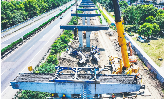
仙桃特大桥施工现场。
