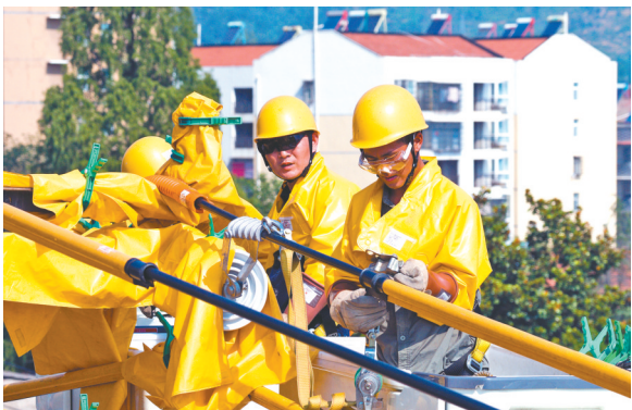
国网随州供电公司员工在广水市进行带电检修作业，保障居民夏日用电。（湖北日报通讯员 冯刚 摄）
