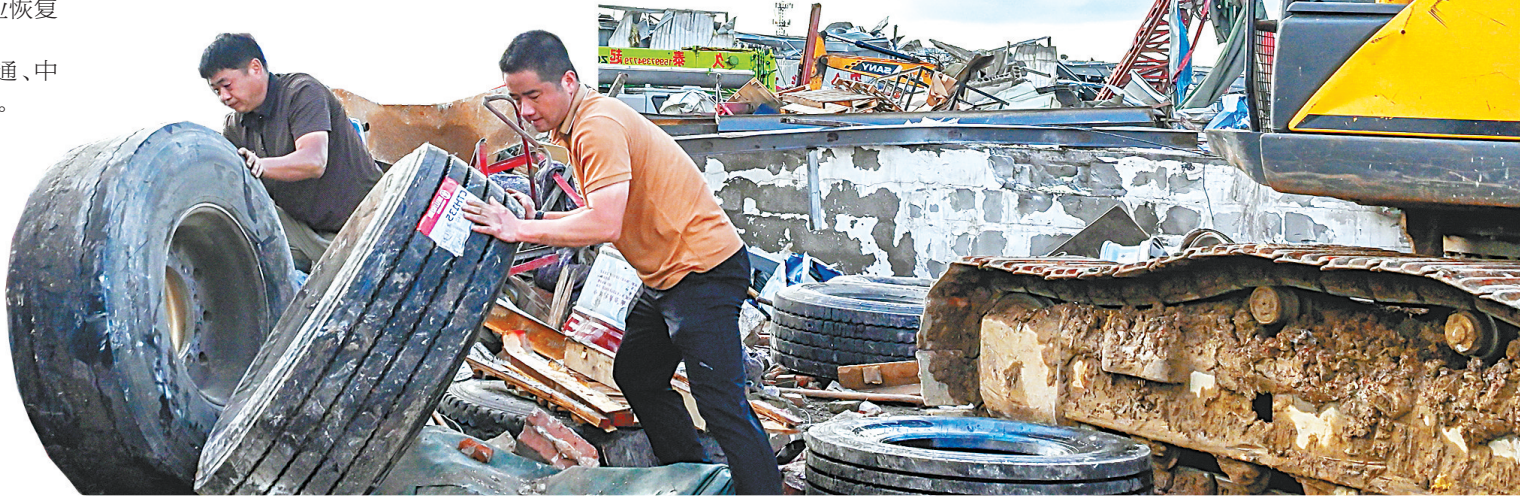
7月7日，在中洲窑炉公司门口，救援队伍与职工协同开展清障修缮、物资转运等重建作业。（湖北日报全媒记者 薛婷 通讯员 王定初 王江 摄）
