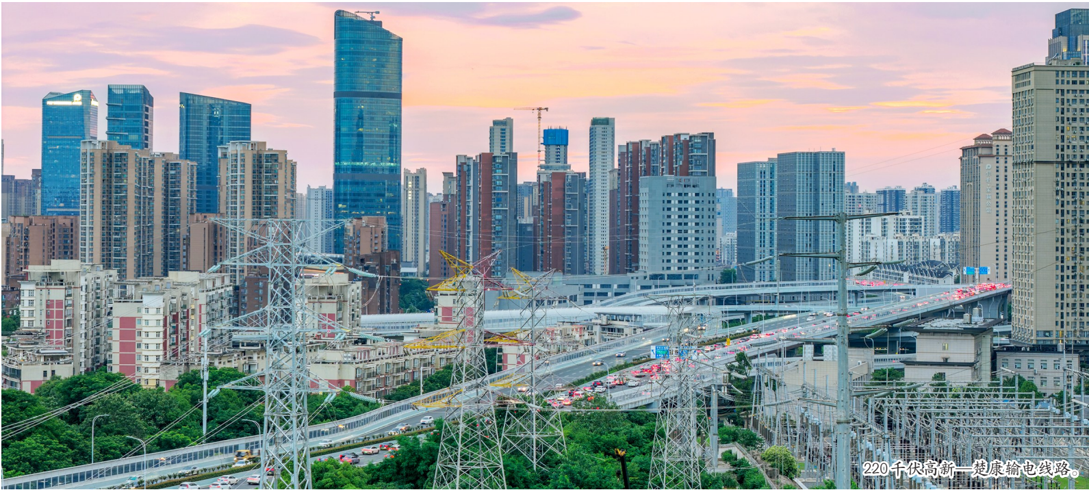
城市地下“电力长龙”建设 攻克诸多施工难题
