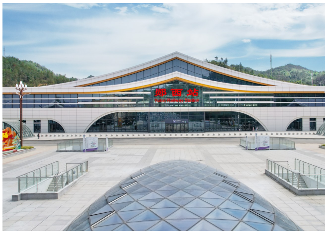
西十高铁鄖西站。
