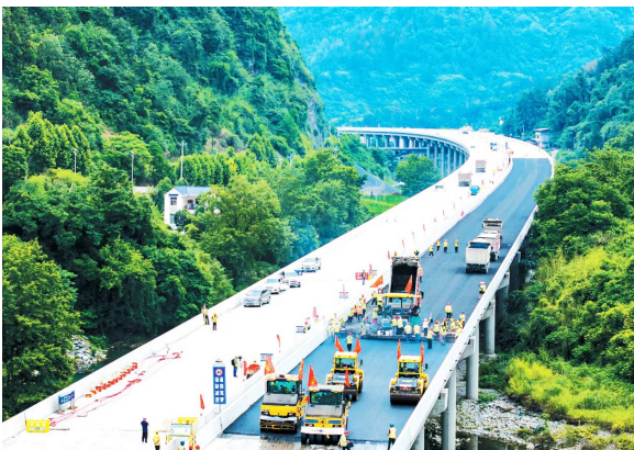
建设中的十巫南高速竹溪段。
