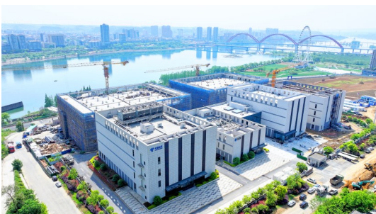
武当云谷大数据中心。
