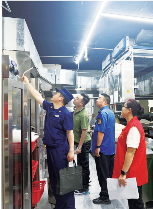
6月3日,十堰竹溪县应急委办统筹多部门力量,聚焦城市运行重点领域、关键环节,开展全覆盖、拉网式城市安全隐患排查行动。
