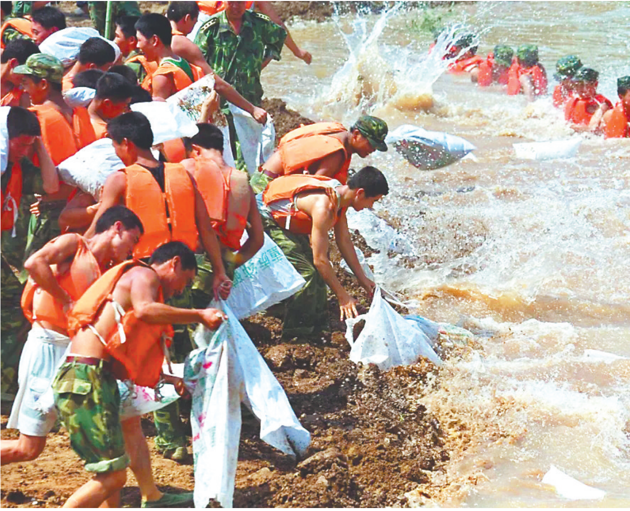
1998年8月11日,湖北石首久合垸乡团山河支堤出现“管涌”险情,解放军官兵立即奔赴险段,以血肉之躯挡住肆虐的洪水,减低洪水的冲击力,同时加固堤防。
