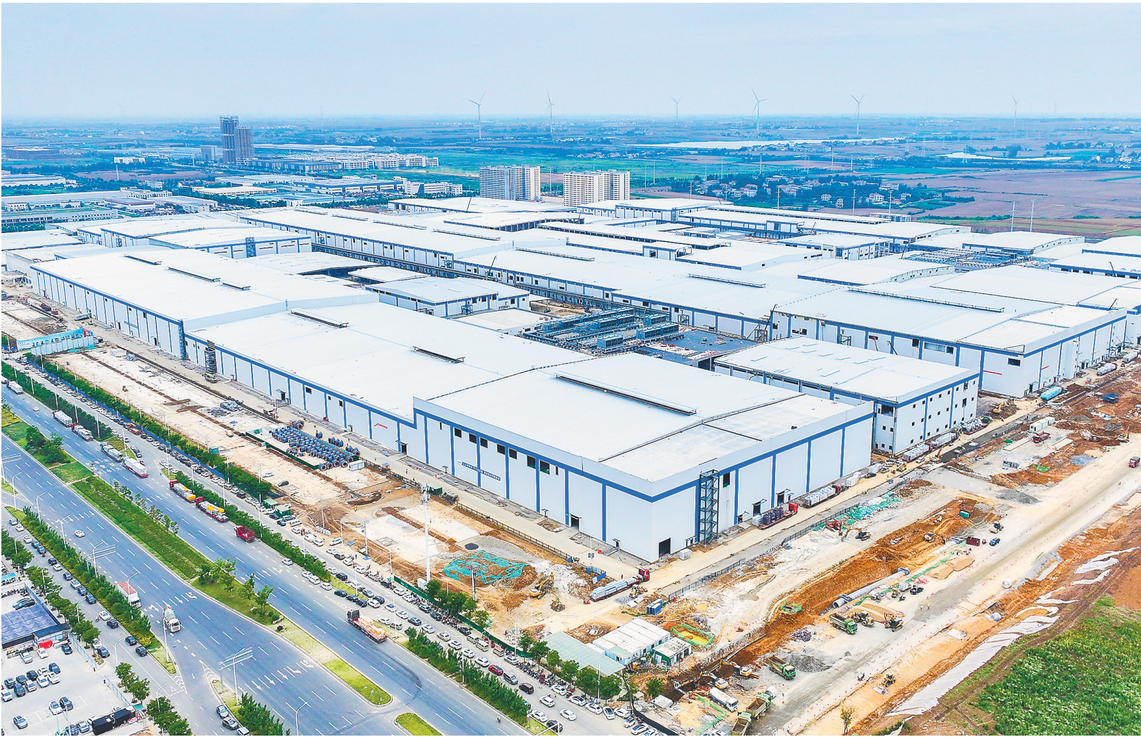
楚能襄阳项目建设现场。(湖北日报全媒记者 赵怡然 摄)
