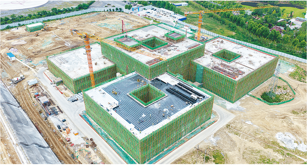
漳河实验室科创中心封顶。(湖北日报通讯员 黎威晗 摄)
